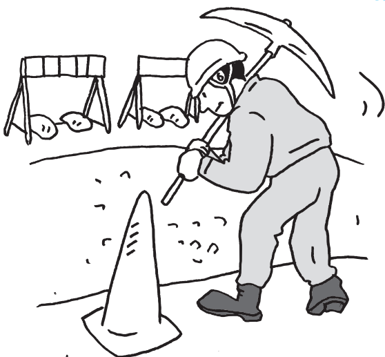
建設工事を施工するとき
