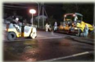
通行不能の交差点での応急工事
