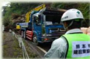
道路啓開(倒木・土砂の撤去)
